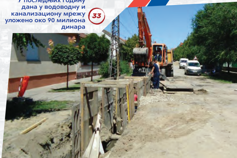
Замена топловода у Микронесељу 31
